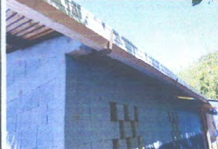
Foto 2: mejoramiento de canales
