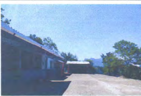
Foto 3: losa de patio
