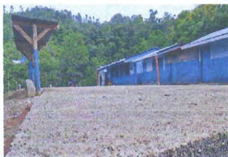
Foto 1: mejoramiento losa de patio
