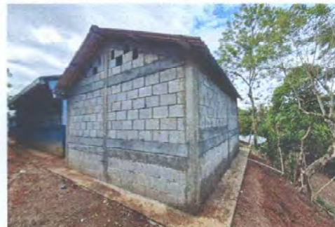
Foto 4: canales y bajadas de agua pluvial
