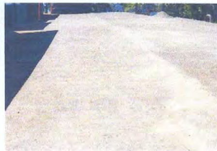
Foto 2: mejoramiento losa de patio
