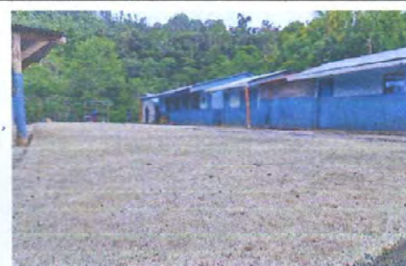
Foto 4: losa de patio
