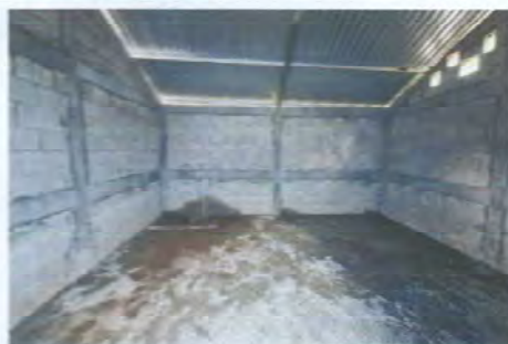
Foto 3: losa de patio
