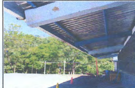
Foto 4: canales y bajadas de agua pluvial
